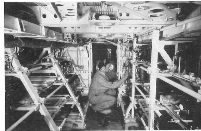
VC-10 Equipment bay Baie des équipements VC-10 VC-10 Geräteraum
